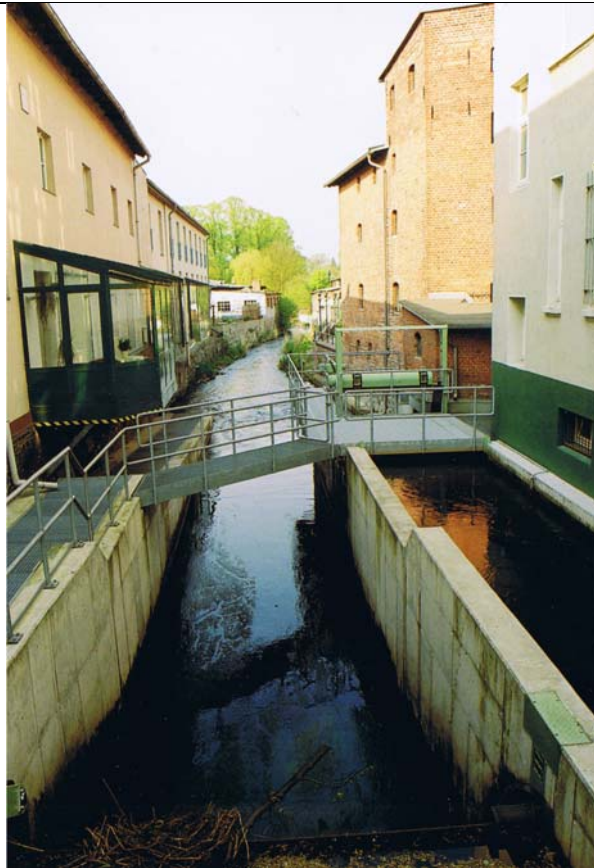
Turbinenanlage an der Stepenitz
