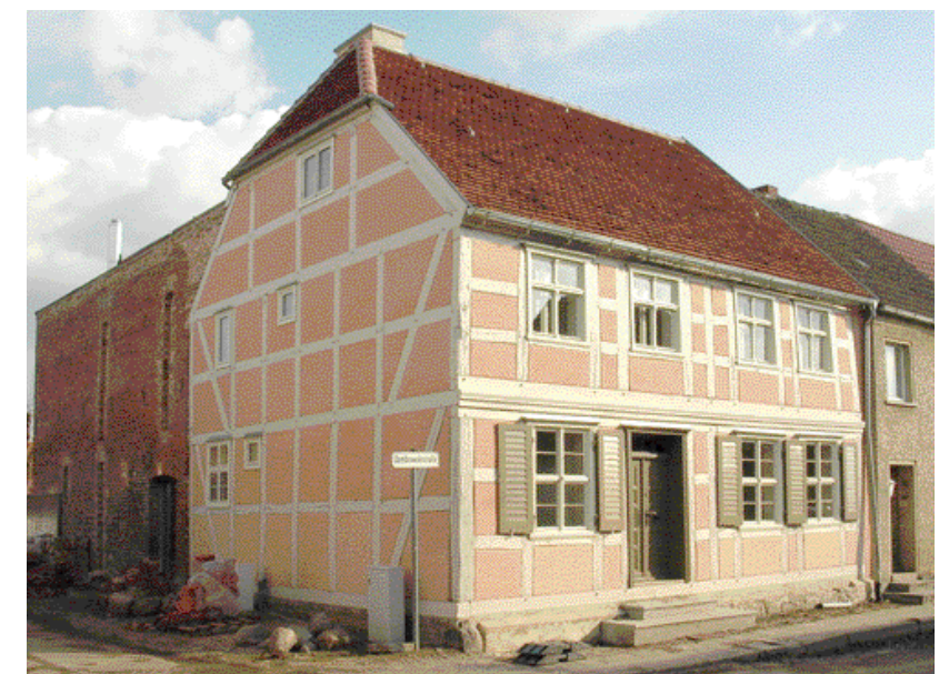
Dombrowskistraße 16 nach der Sanierung
