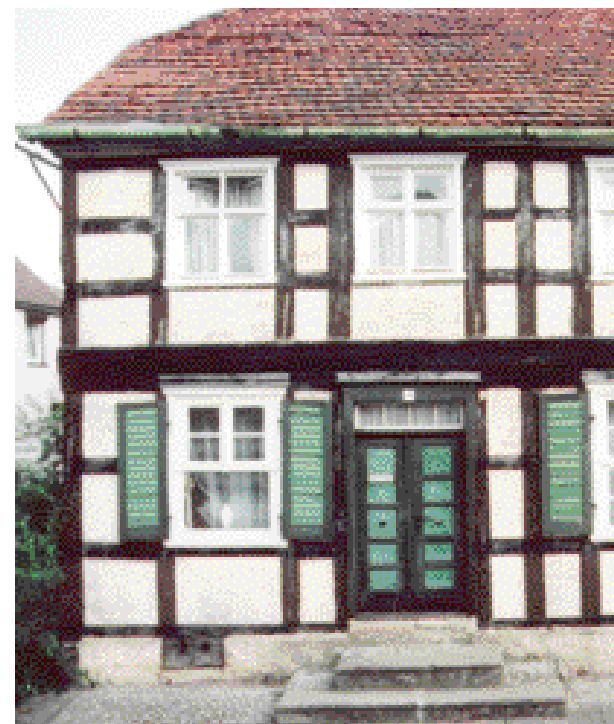
Dombrowskistraße 16 vor der Sanierung
