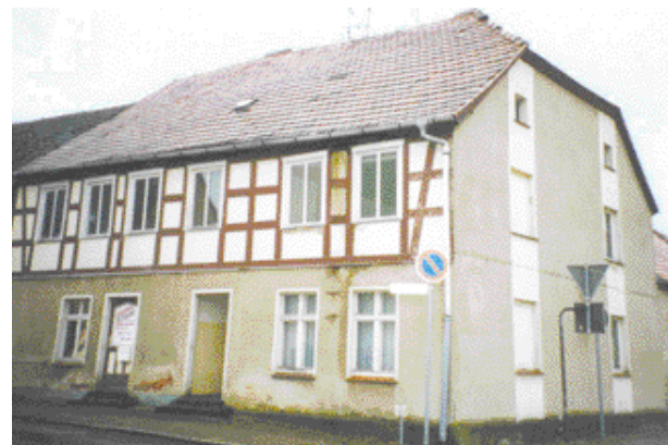
Neue Poststraße 8 vor der Sanierung
