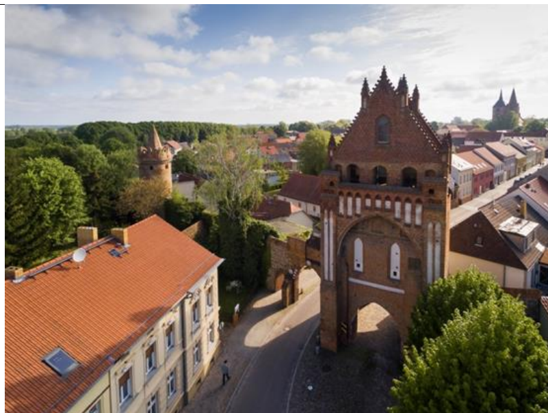
Bild nach Sanierung
