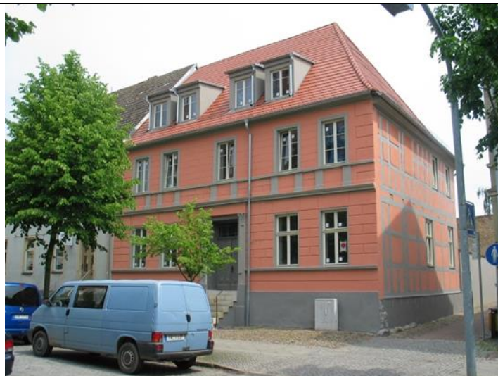
Bild nach Sanierung
