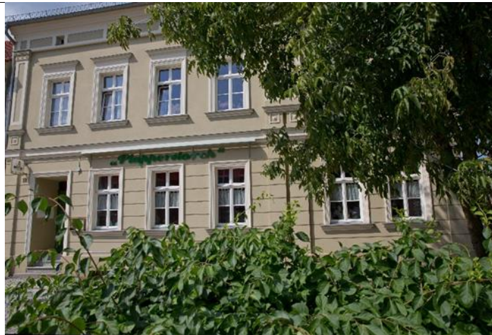
Bild nach Sanierung
