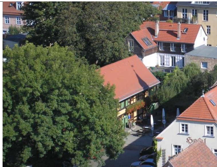
Bild nach Sanierung
