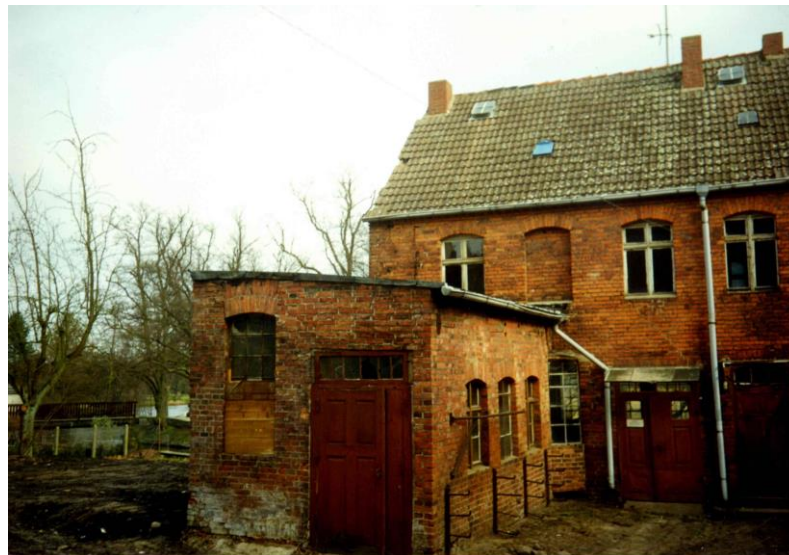
Dateiname Parchimer Straße 11a - vor der Sanierung Bildautor verstorben
