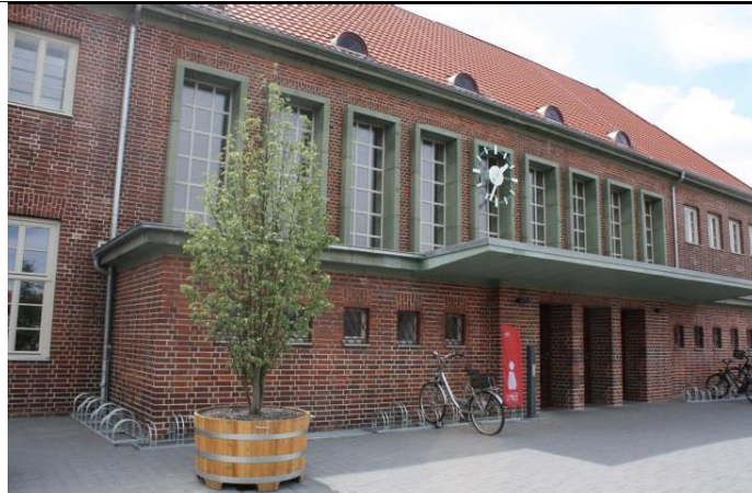
Bild 1: Neues Empfangsgebäude nach der Sanierung (Vorderansicht)
